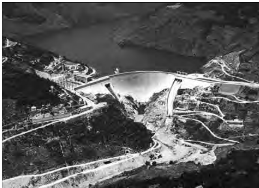
Central de Belesar poco antes de su inauguración, c. 1954
